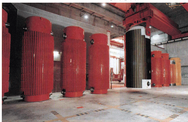
(1)ゴアレーベン中間貯蔵施設(ドイツ)の金属キャスク
